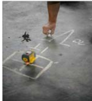
4 Headrigger bei der Arbeitsvorbereitung und Detailplanung
