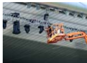
2 Technische Massnahmen zum Schutz gegen Absturz haben immer Vorrang.
